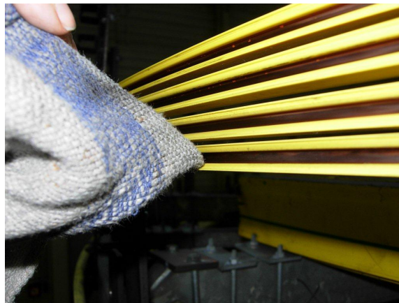
Figure 11: Angle d'inclinaison pour nettoyer la zone inférieure
