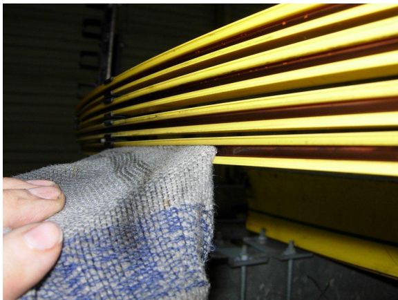
Figure 10: Modifier l'angle d'inclinaison de l'outil de nettoyage pour nettoyer différentes zones
